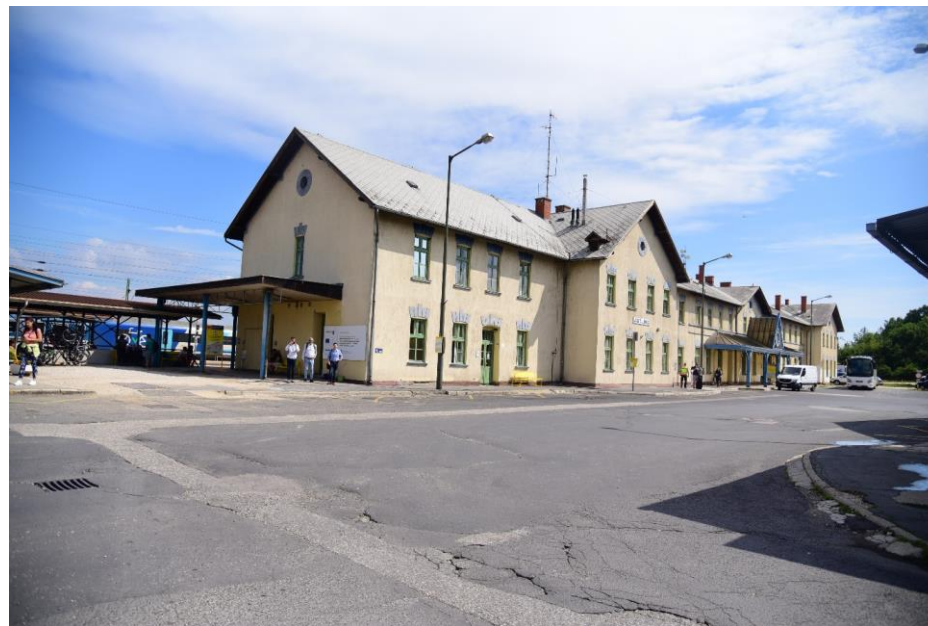
6-17. ábra: Veszprém vasútállomási épület és előtér
