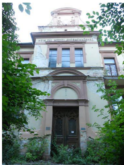
A központi épület homlokzata
