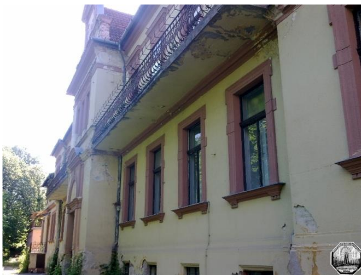
A központi épület homlokzata
