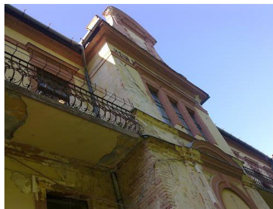
a központi épület homlokzata
