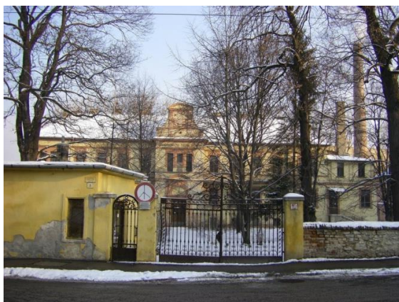
a kórház kapuzata és főépülete
