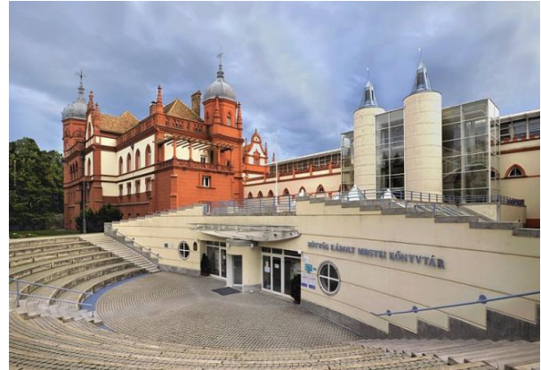
a modern belsőudvari bővítés
