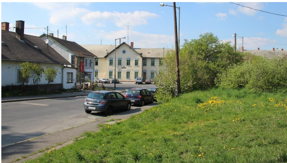
4-68. ábra: A Jutasi úti házak a felvételi épület eredeti középrizalitjával
