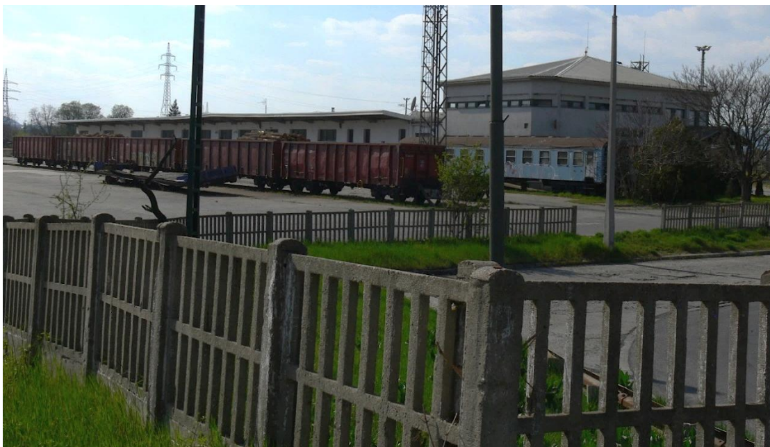
4-66. ábra: Posta üzemi épület
