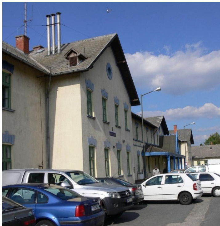
4-65. ábra: Felvételi épület "főbejárat"
