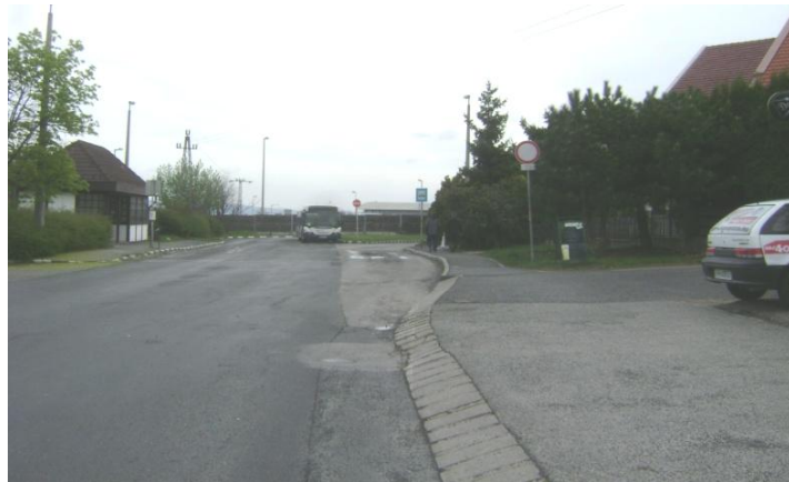
4-12. ábra: Kádártai úti buszforduló
