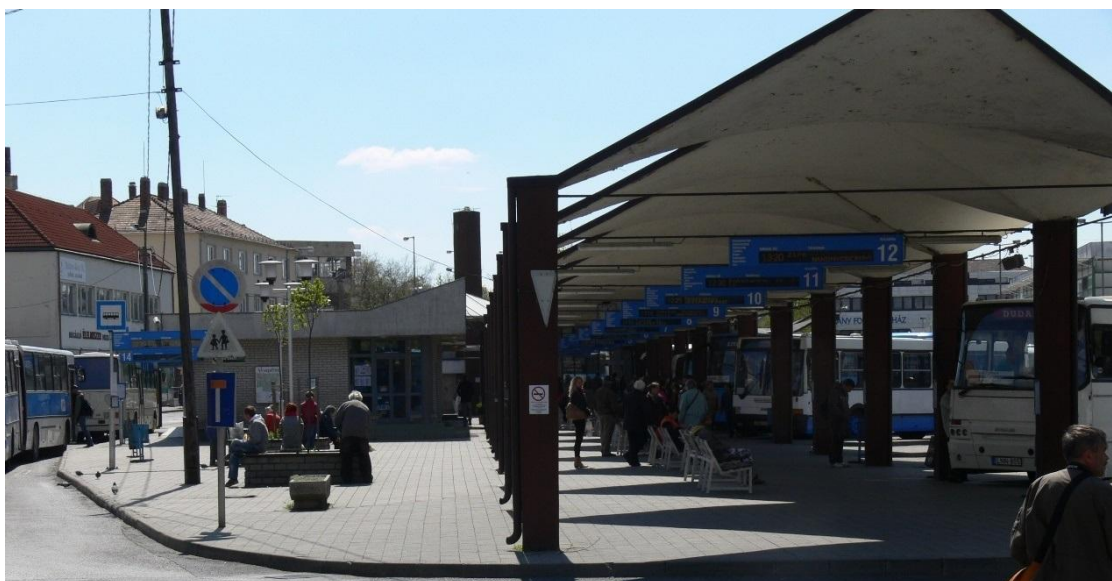
4-80. ábra: A forgalmi épület
