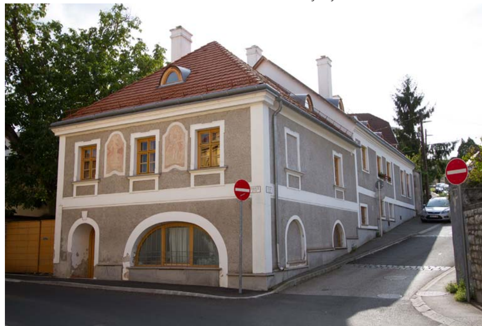
Műemlék épületek homlokzatfelújítása
