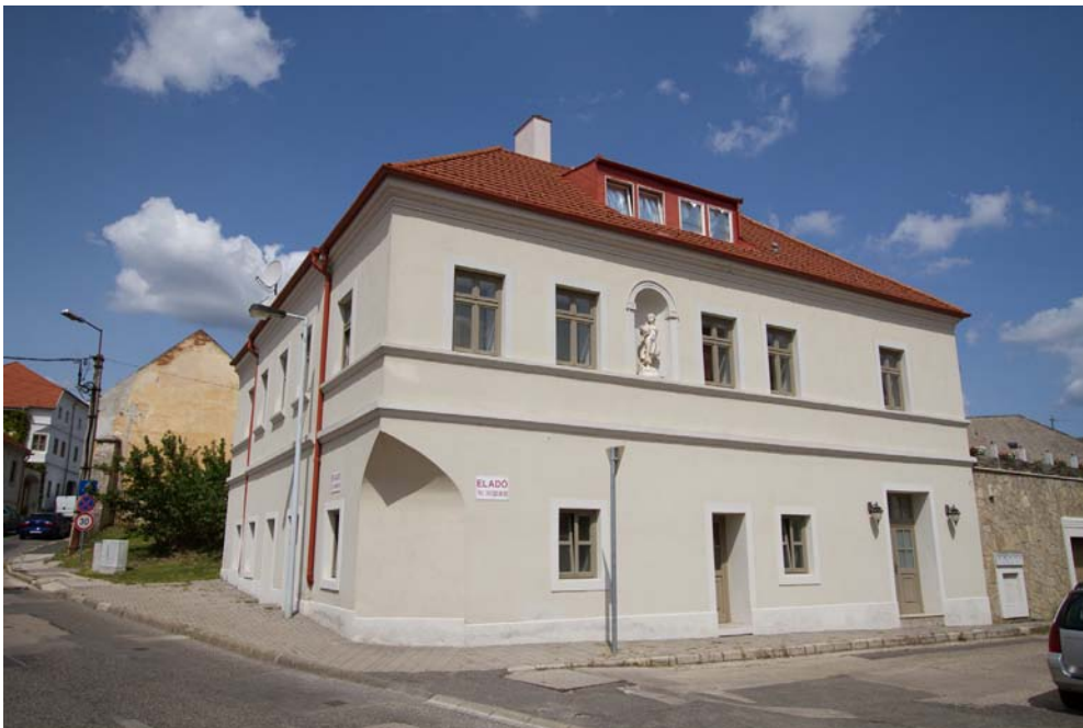
Műemlék épületek homlokzatfelújítása
