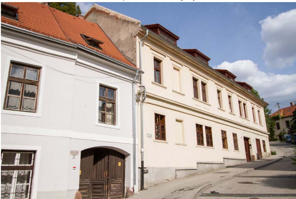
Műemlék épületek homlokzatfelújítása
