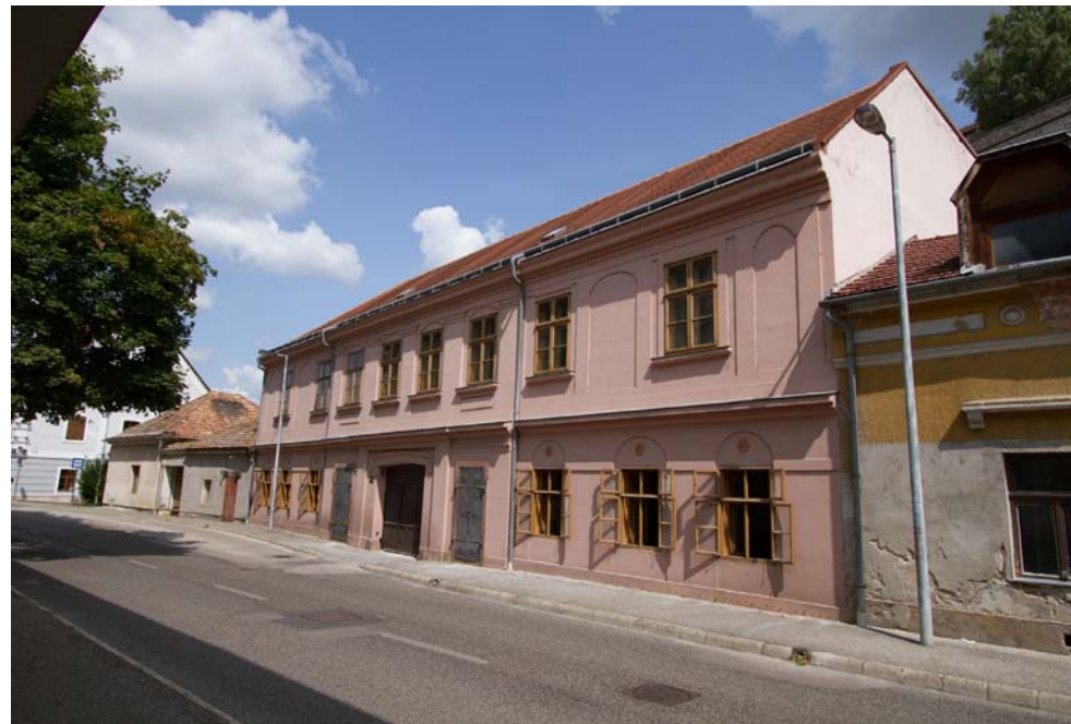
Jókai Mór utcai lakóház homlokzatfelújítása
