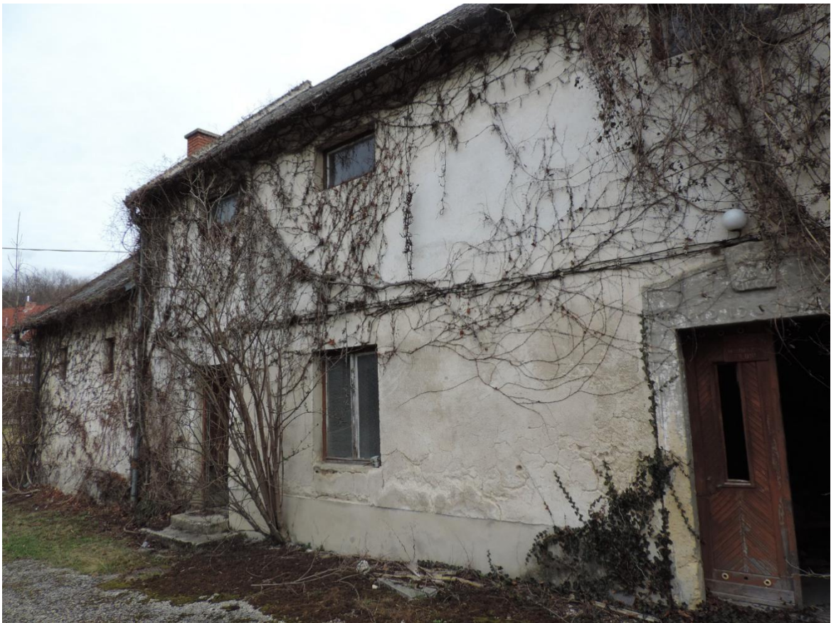
5. A nyugati homlokzat északi része
