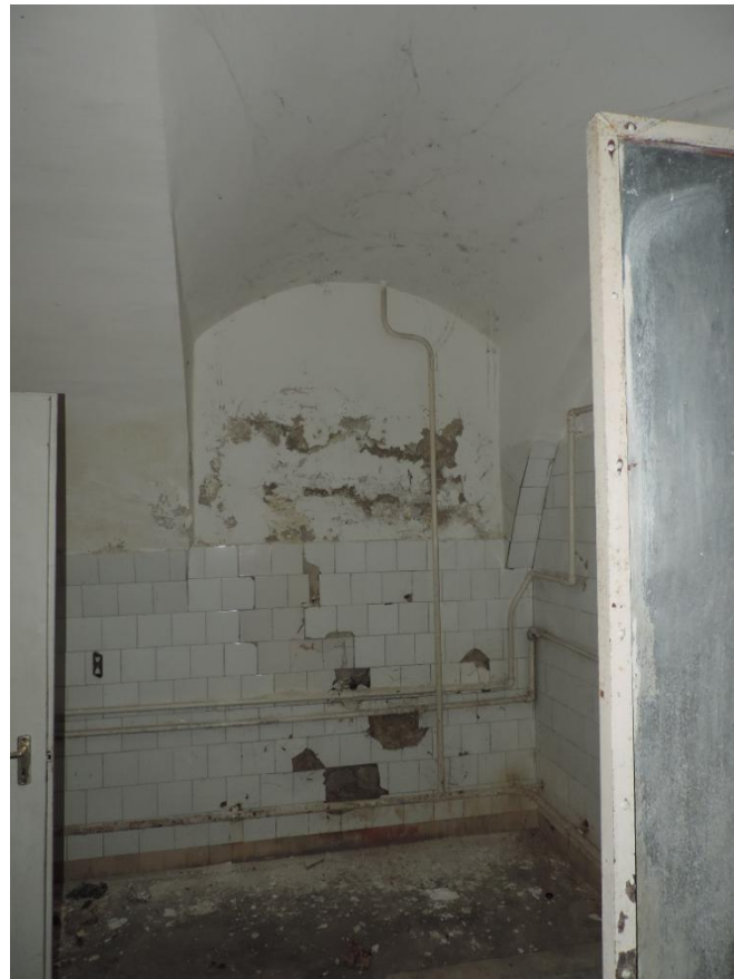
15. A földszint I. helyiségének második boltszakasza
