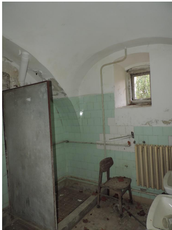
21. A földszint III. helyiségének második boltszakasza
