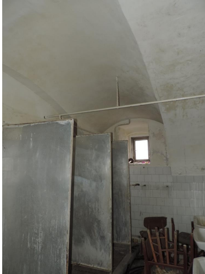
14. A földszint I. helyiségének második boltszakasza
