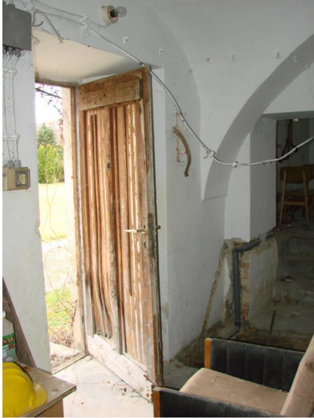
22. Bejárati ajtó a földszint III. helyiségébe
