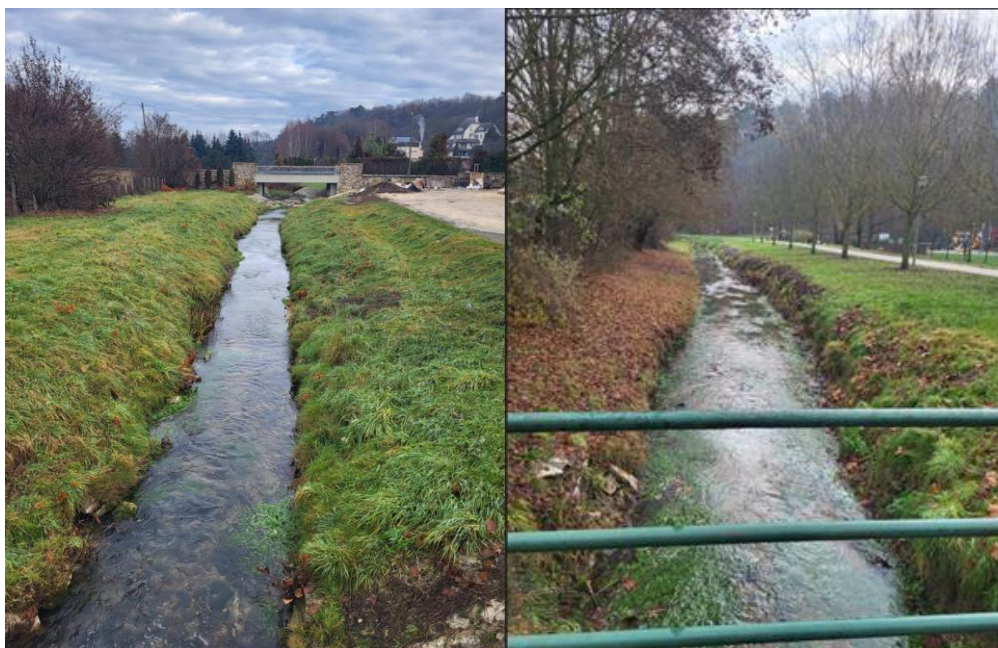
33. ábra Veszprémi-Séd városi szakasza (bal: városi csapadékelvezető csatorna után, jobb: a Betekints-völgyben)
