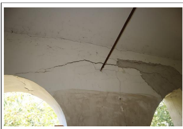
szerkezeti hiba, repedés
