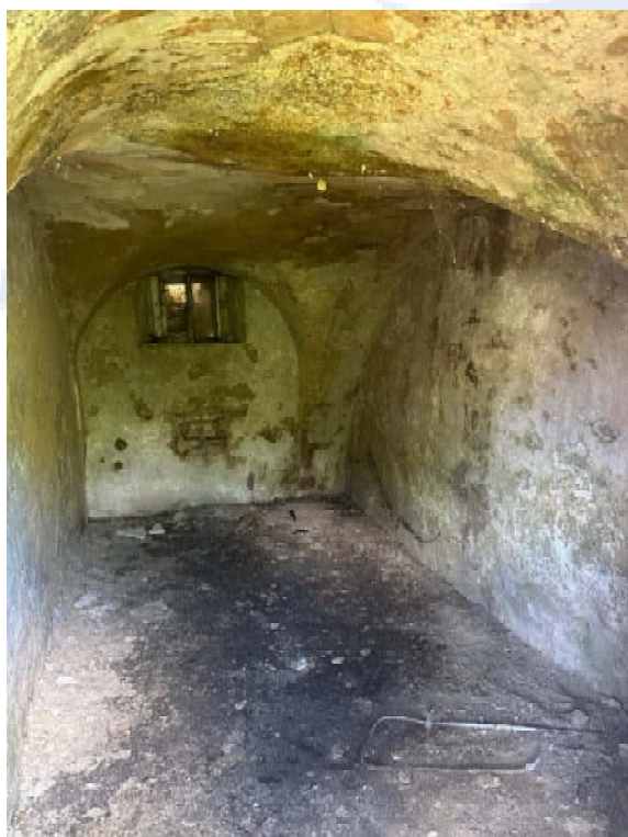
50. ábra A kisebbik pincetér részlete az egykori ajtóból tekintve, jobbra az oldalfal a földnyomástól megvasasodott
