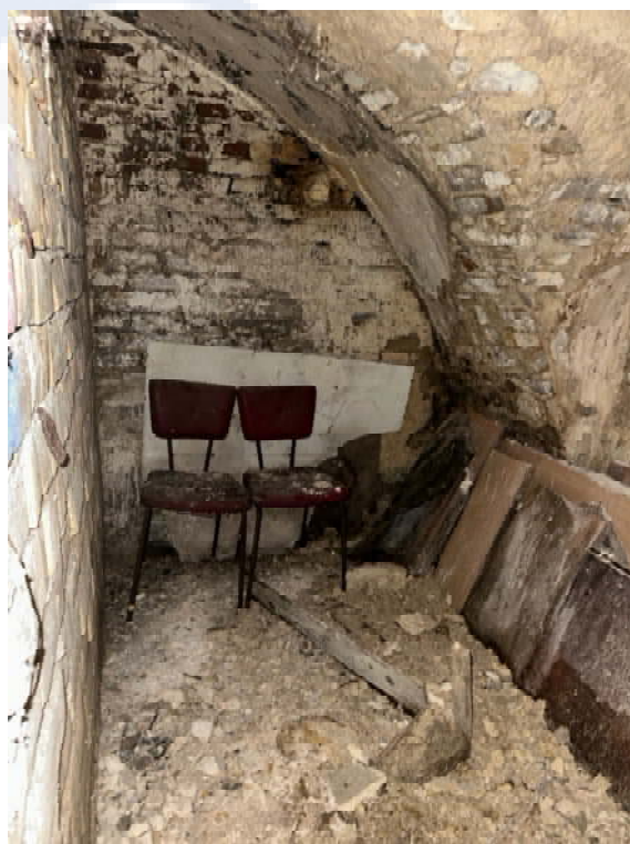
50. ábra A kisebbik pincetér részlete az egykori ajtóból tekintve, jobbra az oldalfal a földnyomástól megvasasodott
