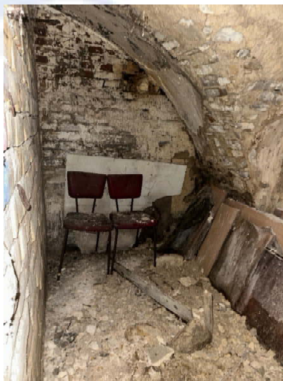
50. ábra A kisebbik pincetér részlete az egykori ajtóból tekintve, jobbra az oldalfal a földnyomástól megghasasodott
