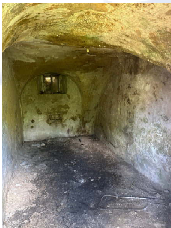
50. ábra A kisebbik pincetér részlete az egykori ajtóból tekintve, jobbra az oldalfal a földnyomástól megghasasodott
