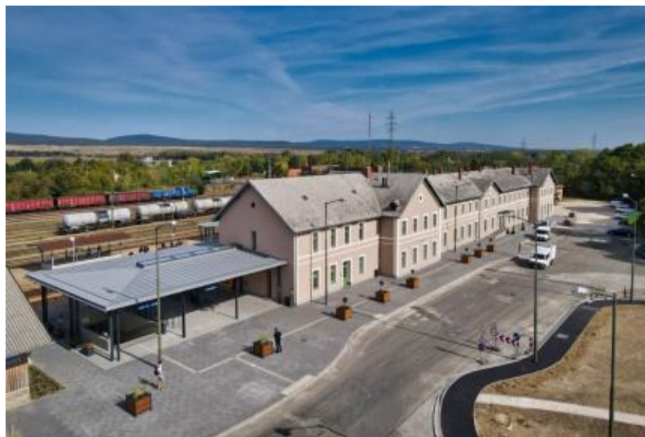
5-10. ábra: Felújított vasútállomás épülete
