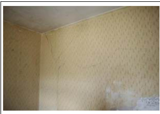
szerkezeti hiba, repedés
