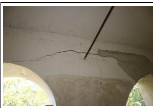
szerkezeti hiba, repedés
