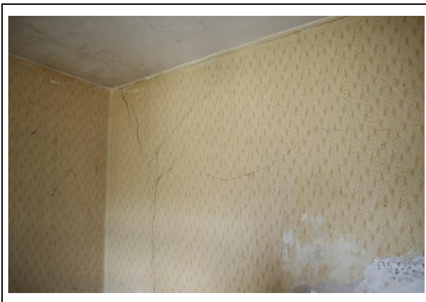
szerkezeti hiba, repedés
