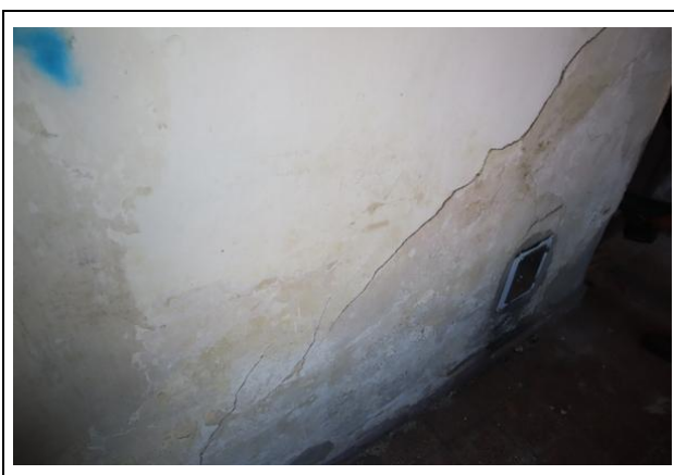
szerkezeti hiba, repedés
