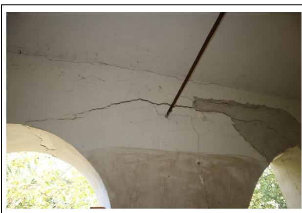
szerkezeti hiba, repedés
