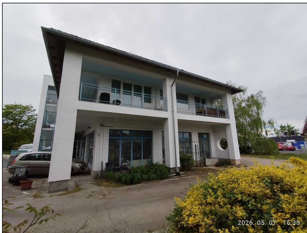
helyszínekép K-felől fotózva (forrás: saját készítésű fotó)
