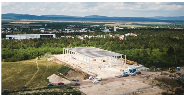
A jégcsarnok építés közben (Forrás: vehir.hu)
